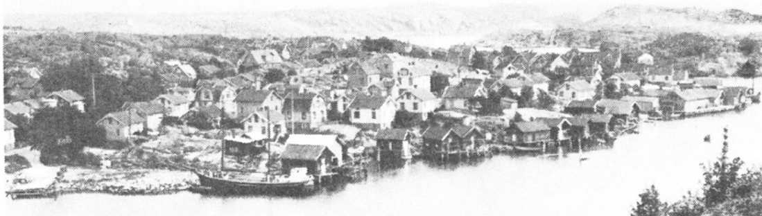
På 1930-talet hade garnbockarna försvunnit, men antalet bodar ökat. Bostadshusen hade målats ljusa och byggts på. Foto: GHM
